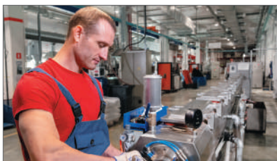
Линии для экструдирования термоусаживаемой трубки
